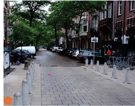
Marquage et matériaux
