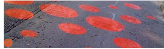
Marquage et matériaux
