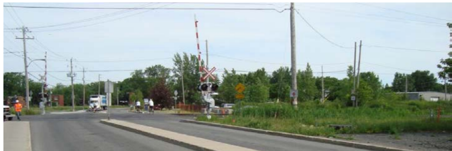
Figure 2.6 Passage à niveau sur la rue Saint-Georges
