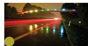
Rue Saint-Thomas: Mise en lumière du viaduc Taschereau
