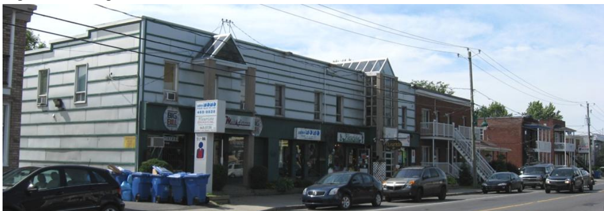
Figure 2.4 Architecture hétéroclite sur la rue Saint-Louis
