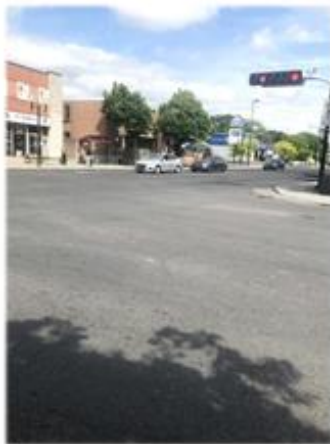
Aperçu de l'intersection Curé-Poirier et Ch. Chambly (photo prise de la station d'essence) : on note que les passages piétonniers sont complètement effacés
