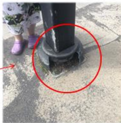
Base du poteau d'arrêt d'autobus est brisée (au coin du Chemin Chambly et du boul. Curé Poirier)
