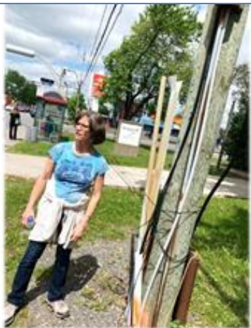
Poteau avec fils accessibles se trouvant sur le terrain de l'ancienne station de pompier
