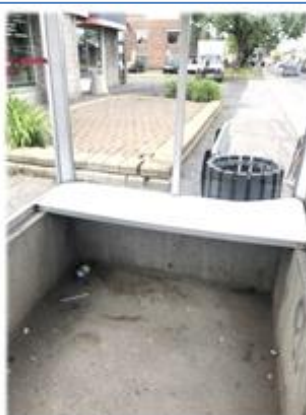
Abribus non accessible car ressaut et entrée trop étroite; de plus, présence d'un banc en métal qui doit être brulant l'été
