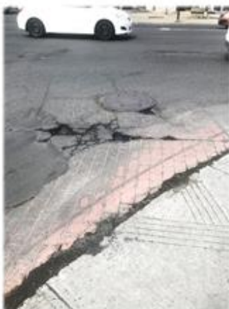
Bateau pavé en mauvais état au coin de Curé-Poirier et Ch. Chambly; passage piétonnier en piètre état et marquage complètement effacé.
