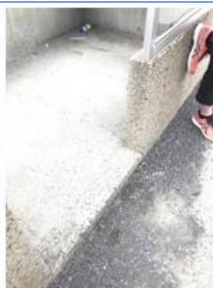
Abribus non accessible car ressaut et entrée trop étroite; de plus, présence d'un banc en métal qui doit être brulant l'été
