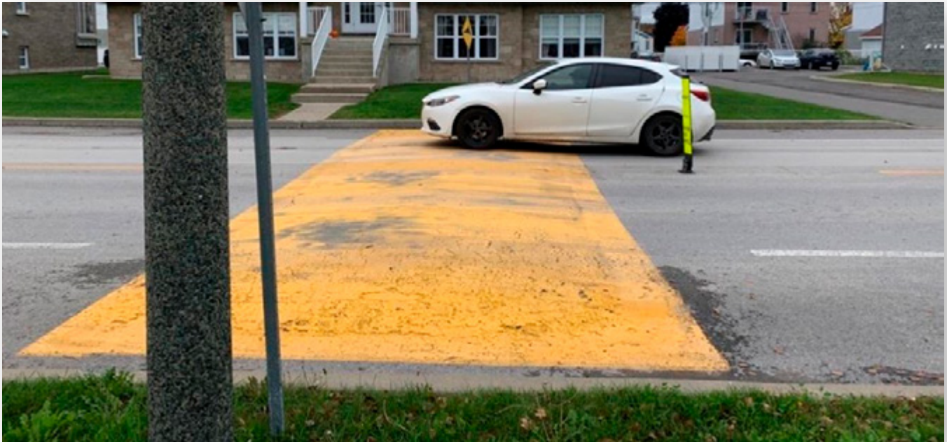
Figure 31 : Dos d'âne, rue Majeau, L'Épiphanie
