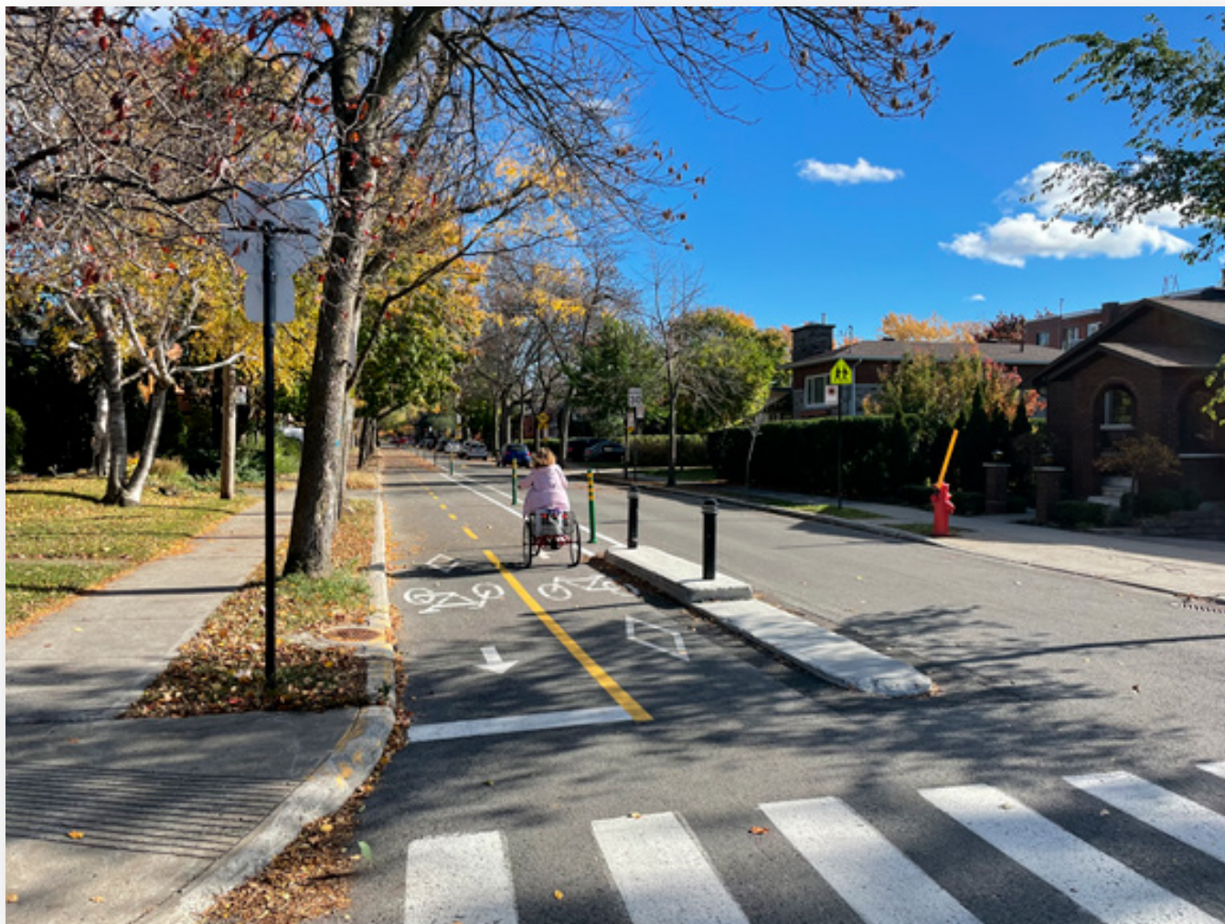
Figure 18 : îlots de béton et délinéateurs, rue Sagard, Montréal
